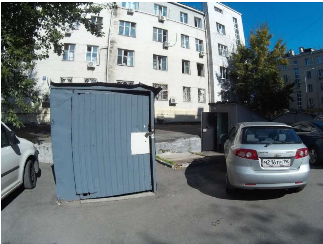
Центральный тепловой пункт Доватора 12 корп.2
